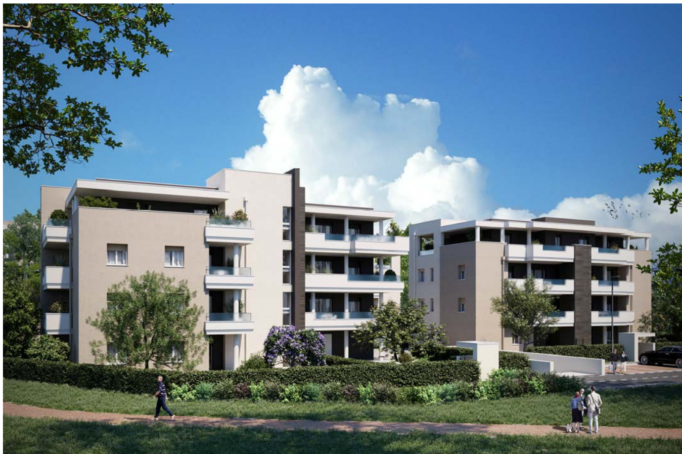
Palazzine Fiordaliso ed Erica, vista lato sud
