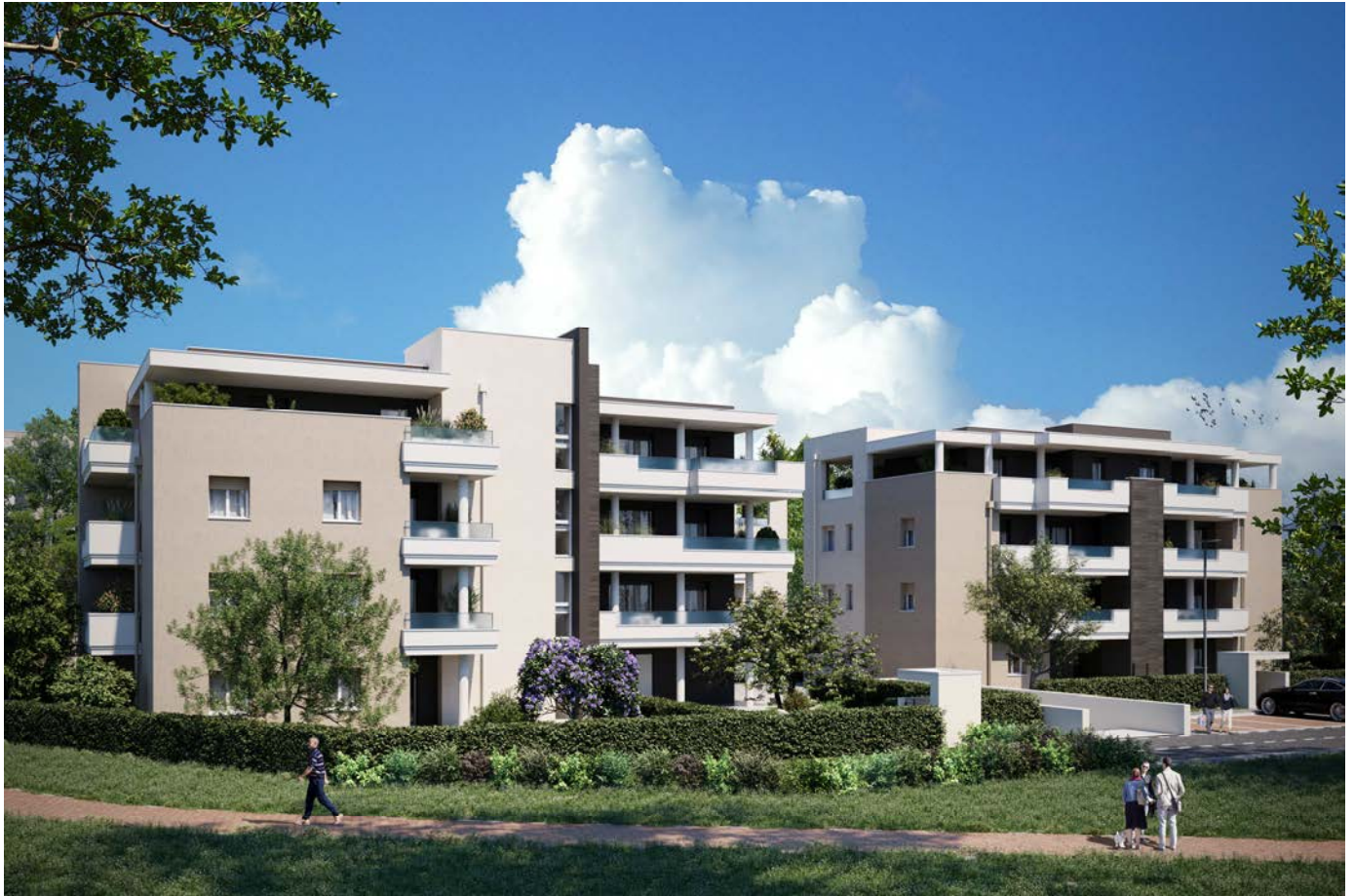
Palazzine Fiordaliso ed Erica, vista lato sud
