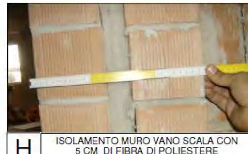
**H** ISOLAMENTO MURO VANO SCALA CON 5 CM DI FIBRA DI POLIESTERE
