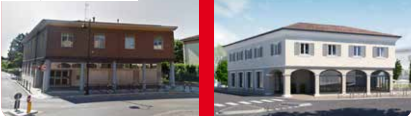
CASINALBO, PRIMA E DOPO L'INTERVENTO
