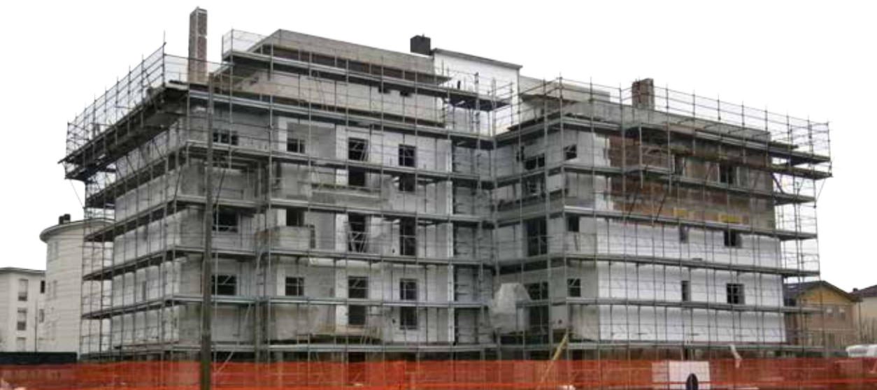
LO STATO DEI LAVORI IN VIA F.LLI ROSSELLI
